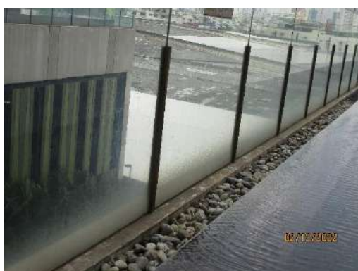
รูปที่ 2-30 รางระบายน้ำล้นรอบสระว่ายน้ำ
