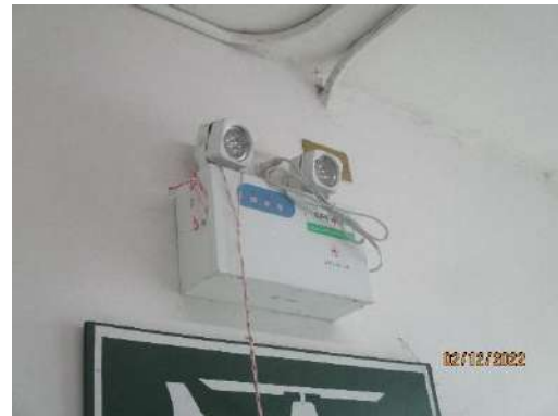
รูปที่ 2-46 ระบบไฟฟ้าส่องสว่างฉุกเฉิน
