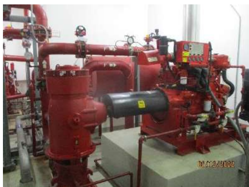
รูปที่ 2-23 ระบบสูบน้ำในอาคาร
